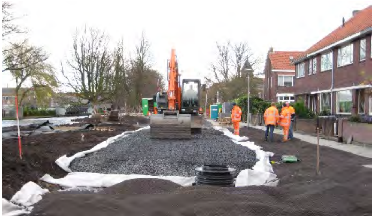
aanleg waterbergende weg in Gouda
